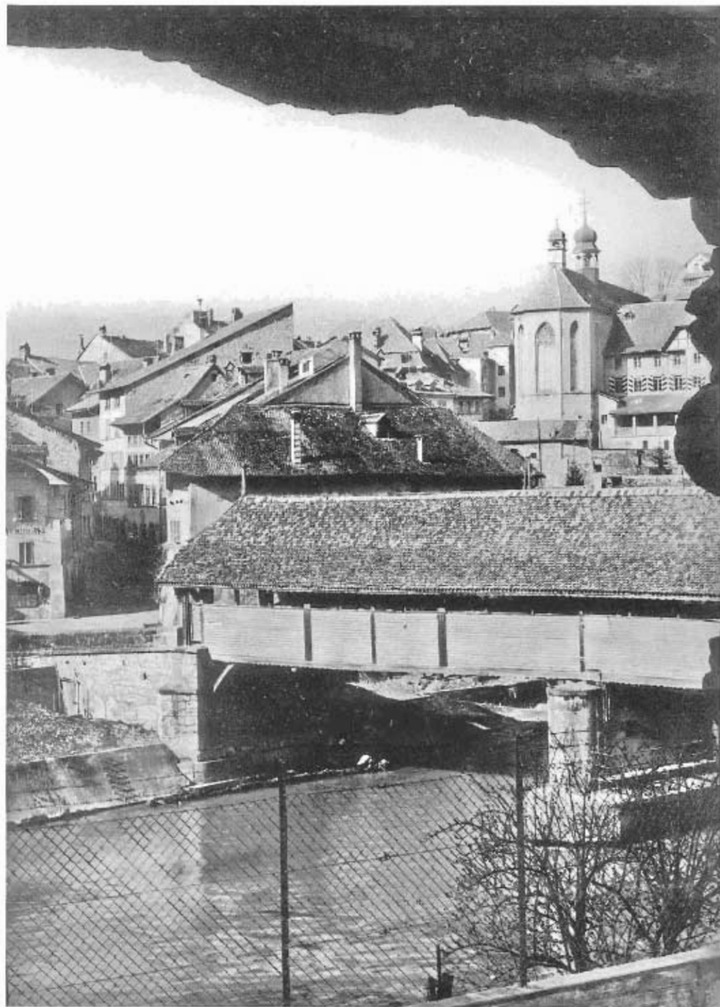
Le pont de bois sur la Sarine
